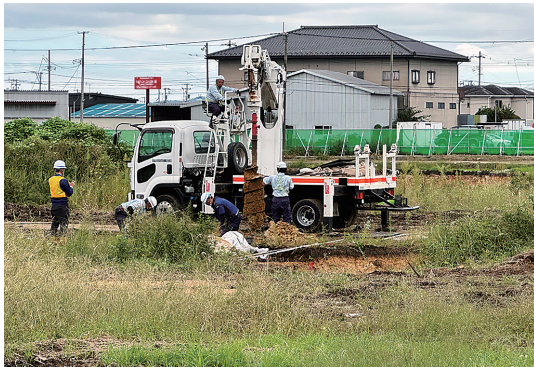
写真-2 GPR探査と試掘の所要時間の比較の様子
