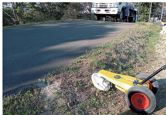
写真-1 電柱立替工事前のGPR探査
