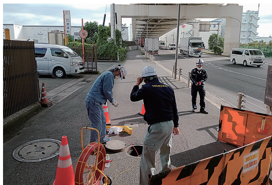
写真-3 EMによる管路の追跡調査の様子
